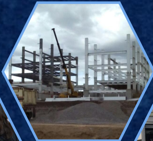
Construcción de Obra civil
